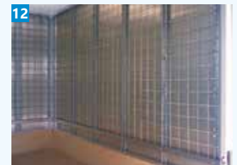
内張り変更 (金網張り+合板張り)
