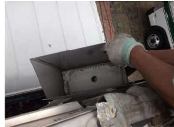
交換するセンターシートを剥がしていきます。シールテープも全て剥がしてください。雨受け等の臓装品がついている場合は、予め外しておくとう作業がしやすいです。
