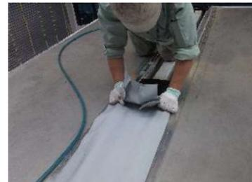
センターシートのヒンジへの噛み込み防止に、薄いゴム板を取り付けると効果的です。
