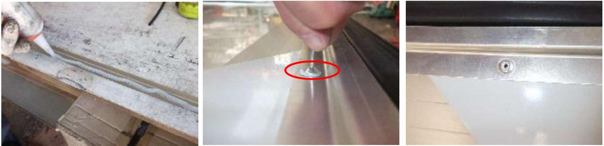
雨トイ取付前に、取付部分にシールを施工してください。
