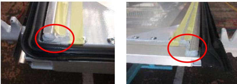
雨トイの端部はシールで壁を作るように施工をして下さい。
