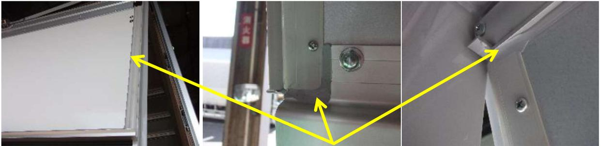
まず最初に、ドア表裏両面のウェザーストリップ周囲のシーリングを切ります。
