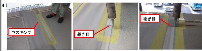
新しく貼ったシールテープの上にシーリングをします。まずシーリング部分を決めて、マスキングします。マスキングをしたら、シールテープの前後の継ぎ目からシーリングをしていきます。
