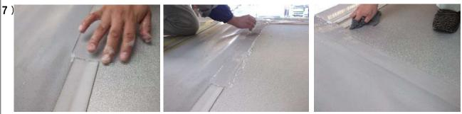
シーリングの側面を手でならし、なだらかにして段差をなくします。 ならしが終わったら、シーリング周囲に飛んだ汚れ等をノルマルヘキサンで拭き取ります。
