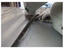
まず最初に、シールテープが剥がれている部分を切り取り、除去します。次に、除去した部分の糊の 残りと、センターシートが剥がれている部分の両面テープの残りかすを、ヘラやカッターで剥がします。 その後、ノルマルヘキサンで粘着の糊の残りを完全に拭き取ります。シンナーは使用しないでください。 ※粘着の糊が残っていると新しい両面テープの接着に大きく影響しますので、完全に拭き取って下さい。
