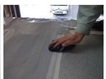
切り取ったシールテープ部に新しいシールテープを貼ります。 その際、元のシールテープとは突き当てになるように貼ります。重ねないように注意して下さい。 シールテープ上面の保護シートを剥がし、ノルマルヘキサンで汚れや油分を完全に拭き取ります。 この後シールテープ上面周囲にシーリングを施工するため、テープ上面より少し広範囲で拭き取りを して下さい。
