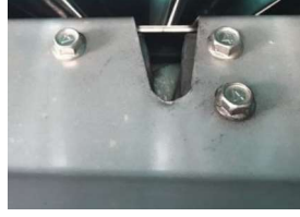
②ラッチ部の増し締め
