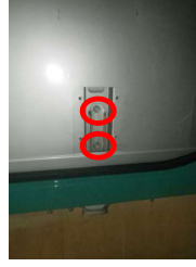
③ボルトを緩めドアチリ調整後再締付
